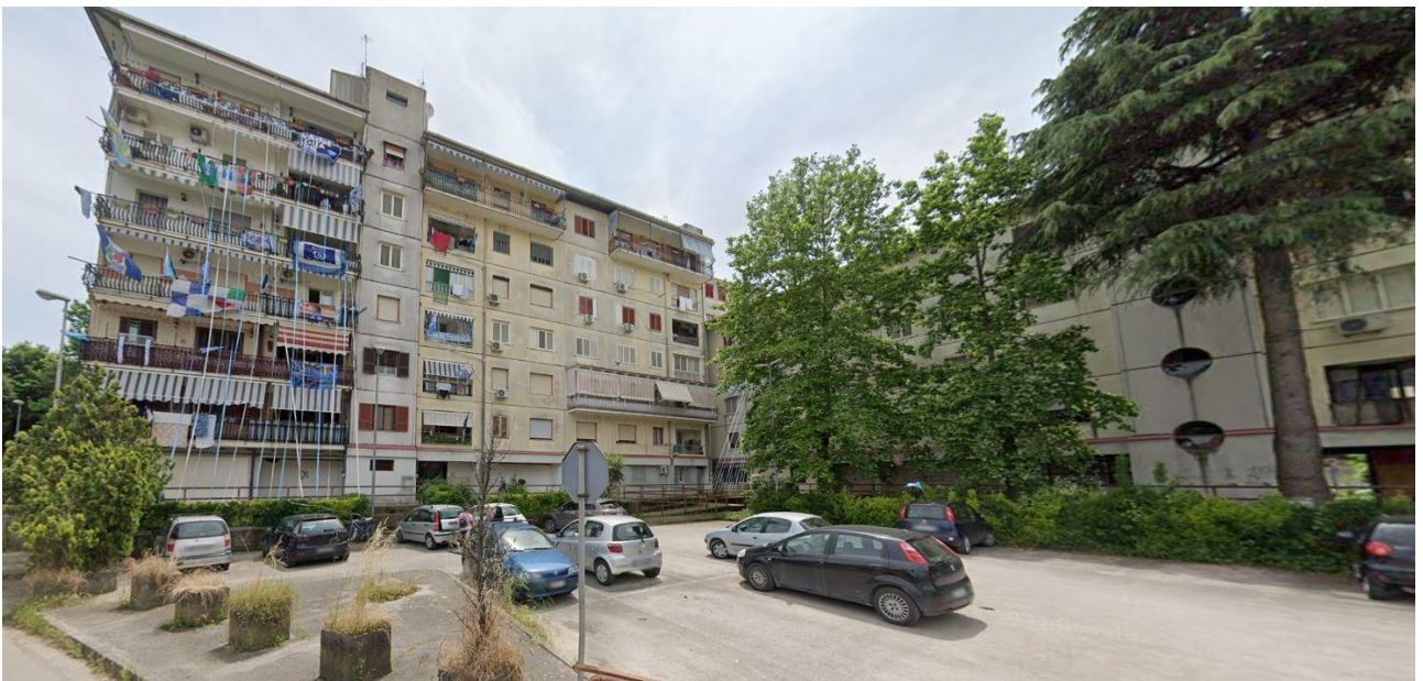
Figura 36: via Po Lato C_P3
