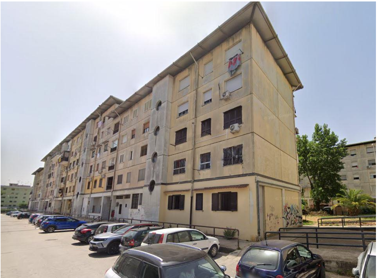
Figura 34: via Tevere Lato A_P2
