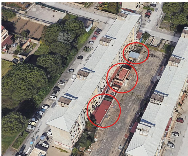
Figura 3: via Praga - lato B - corpi di fabbrica collegati all'edificio
