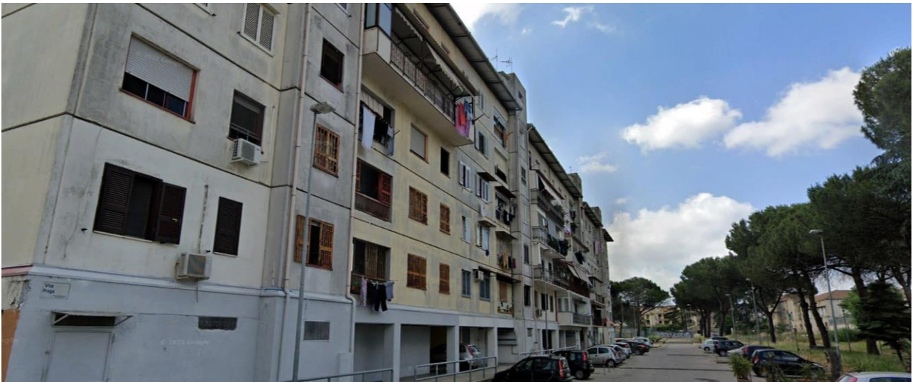
Figura 8: Via Praga - lato A
