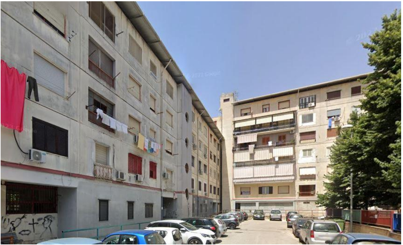
Figura 35: via Tevere Lato A_P3
