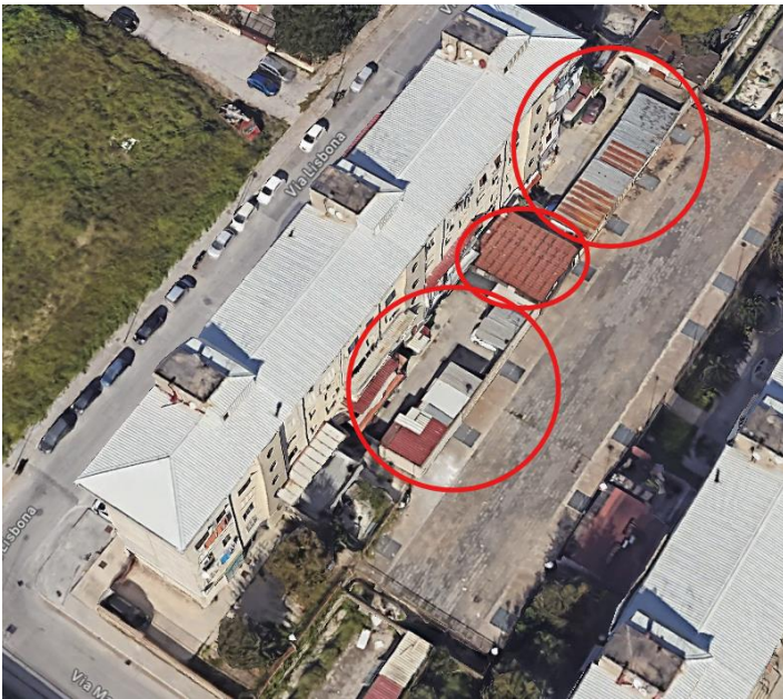
Figura 4: via Lisbona - lato B - corpi di fabbrica collegati all'edificio
